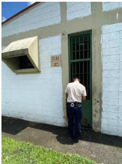
Foto: Celda de aislamiento B-1
