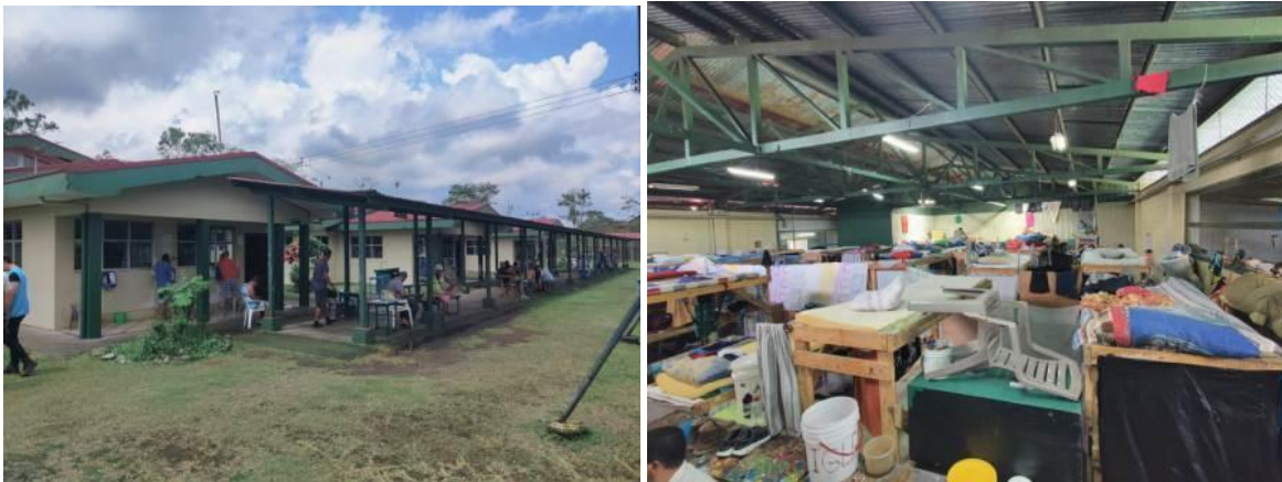
Fotos: izquierda, pabellón D; derecha, pabellón C.
